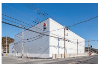
定温倉庫外観
