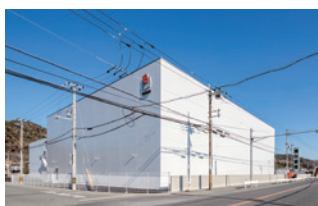
定温倉庫外観
